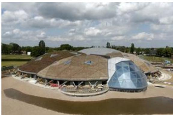
Рис. 13. Проект деревянного сооружения, состоящего из 5 параболоидов вращения
