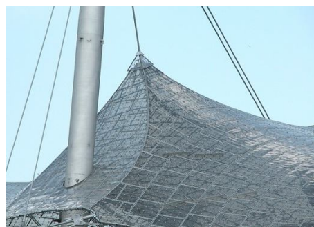
Рис. 4. Фрагмент покрытия Олимпийского стадиона в Мюнхене, Германия
