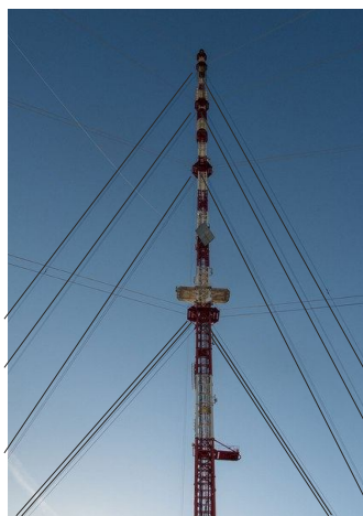
Рис. 30. Мачта переизлучателя с вантовыми растяжками, http://vk.com/wall-13502584_2023
