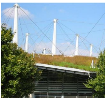
Рис. 9. Подвесная крыша в Лионе (suspended greenroof in Lyons, photo by Haven Kiers )
