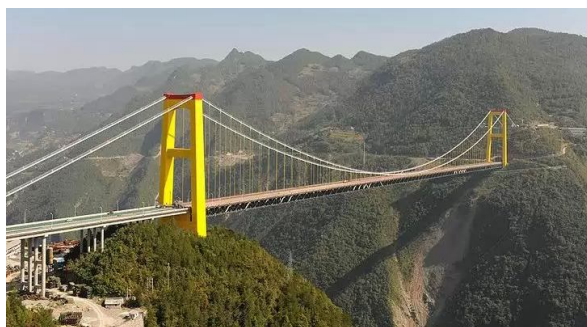
Рис. 33. Цепной мост Siduhe River Bridge, 2009 год. Длина главного пролета – 900 м, высота перекрываемого пространства - 496 м до дна ущелья.
