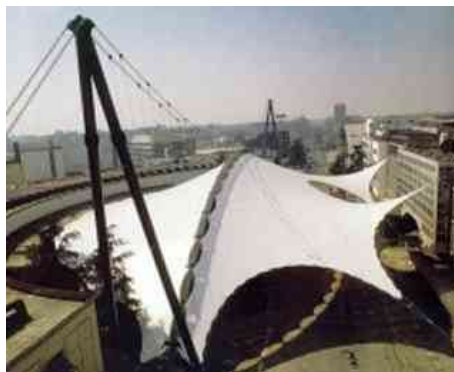
Рис. 13. Подвесное покрытие с продольной вантовой системой, Милан, Италия
