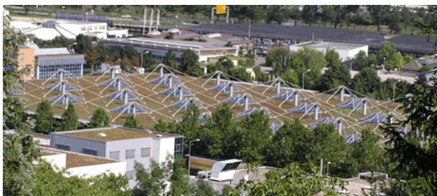
Рис. 10. Зеленая крыша в Штутгарте (Green roof Service LLC, Stuttgart, Germany, photo by G. Breuning)
