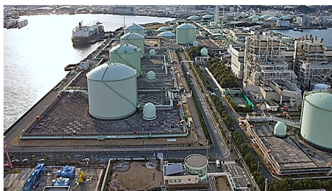
Рис. 1. Вертикальные цилиндрические резервуары из алюминиевого сплава, построенные в Японии в 1960 г. (фото сделано в 2025 г.)
