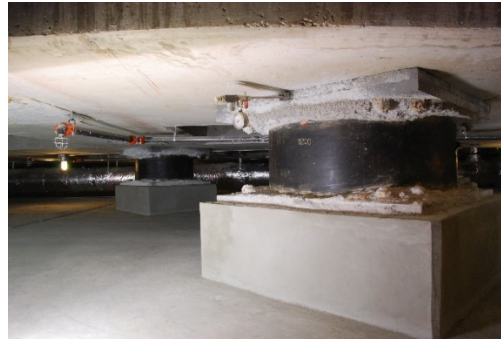
Рис. 1. Цилиндрические резиновые опоры
