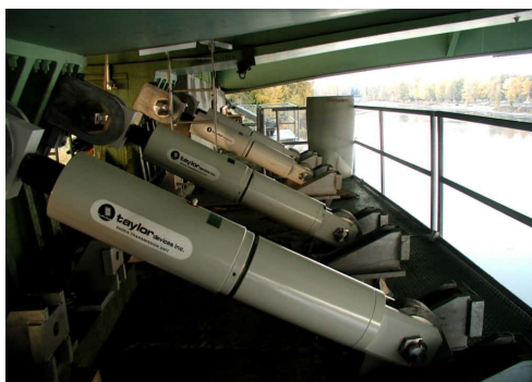
Рис. 4. Вязкостный демпфер И с т о ч н и к: https://www.taylordevices.com/direct-acting-damping/
