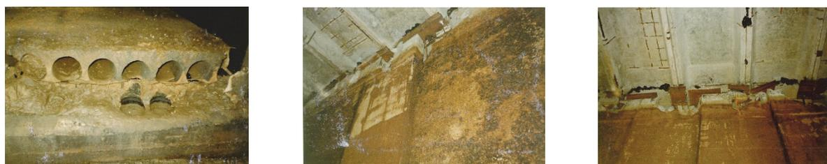
**Рис. 4.** Износ и разрушение элементов конструкции крупногабаритного отстойника ПАО «Нижнекамскнефтехим»
