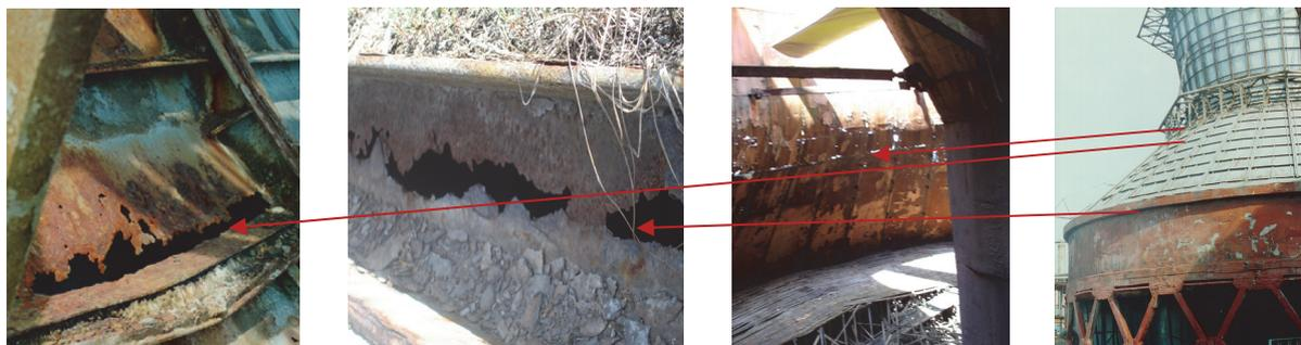
**Рис. 3.** Коррозионный износ элементов конструкции крупногабаритной градирни ПАО «Нижнекамскнефтехим»
