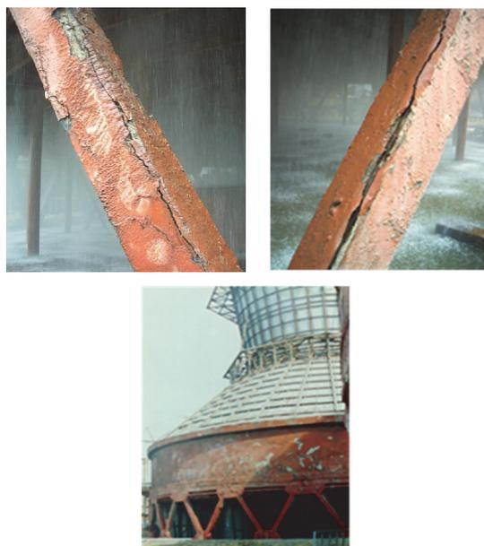
**Рис. 1. Продольные угловые трещины в наклонных стойках крупногабаритной градирни СК-1200**
