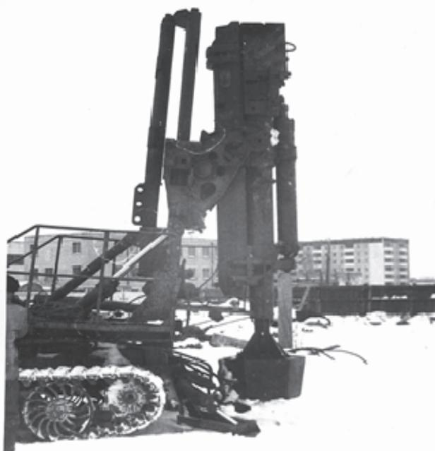
Рис. 4. Установка УЗАС-2 с застреливаемым в грунт штампом
