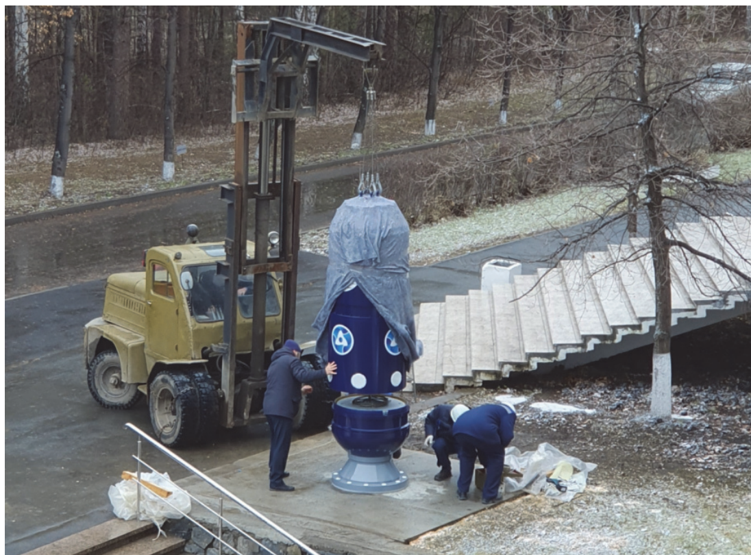
Рис. 2. Установка верхней части стелы на нижнюю тяжелую часть (фото А.Г. Юдова) Figure 2. Mounting the stela top part on the heavy bottom part (photo by A.G. Yudov)
