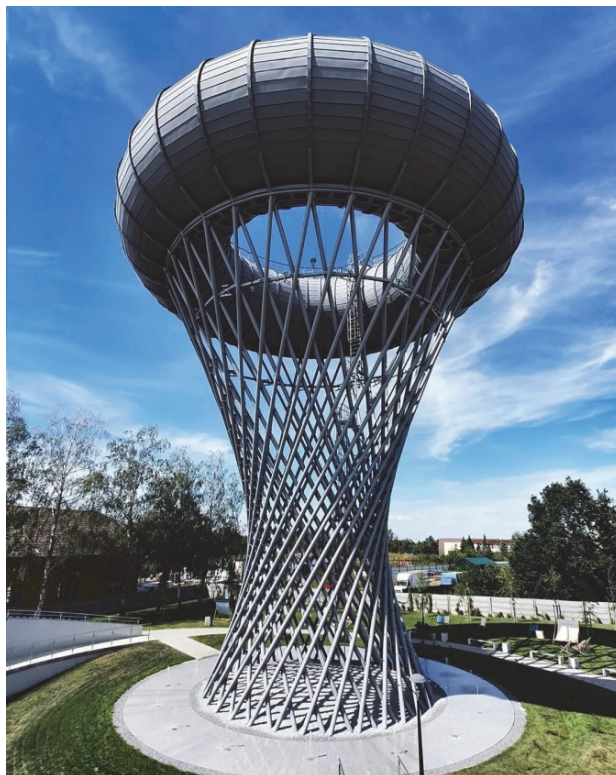
Рис. 8. Водонапорная башня Цеханува, Польша Figure 8. Ciechanow water tower, Poland
