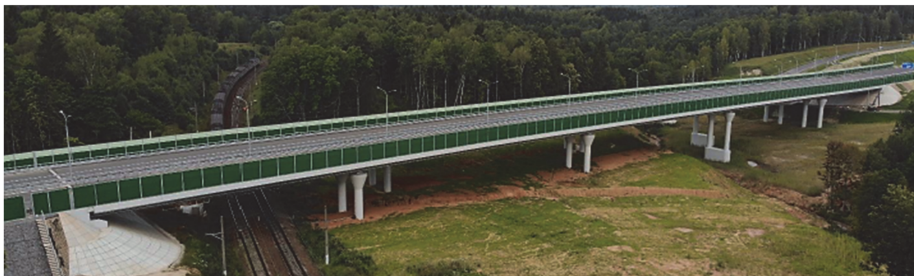
Рис. 6. Путепровод через МЖД на км. 8 + 783 на обходе Калуги (фото Е.А. Луговцева)
