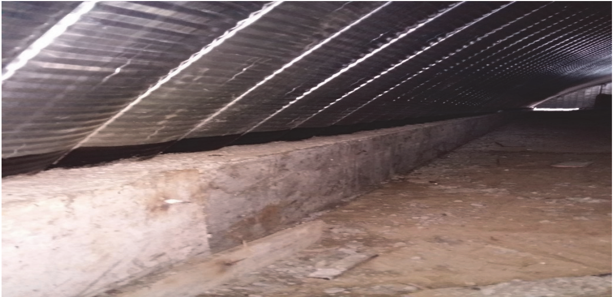
Рис. 6. Ленточный ростверк фундамента здания высотой 0,5 м (фото Д.М. Хусаинова) Figure 6. Capping beam of the building foundation with a height of 0.5 m (photo by D.M. Khusainov)
