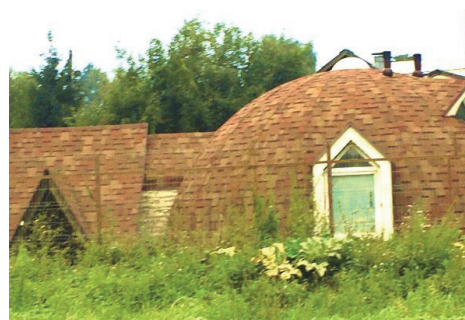
Рис. 4. Купольный дом, Московская область (фото С.Н. Кривошапко)
