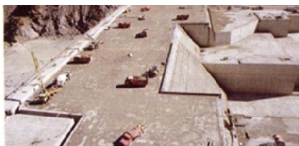
Рис. 9. План гидроузла Синдере с плотиной из УБ-1, водосливом и приплотинным зданием ГЭС (длина плотины по гребню – 280 м) [20]
