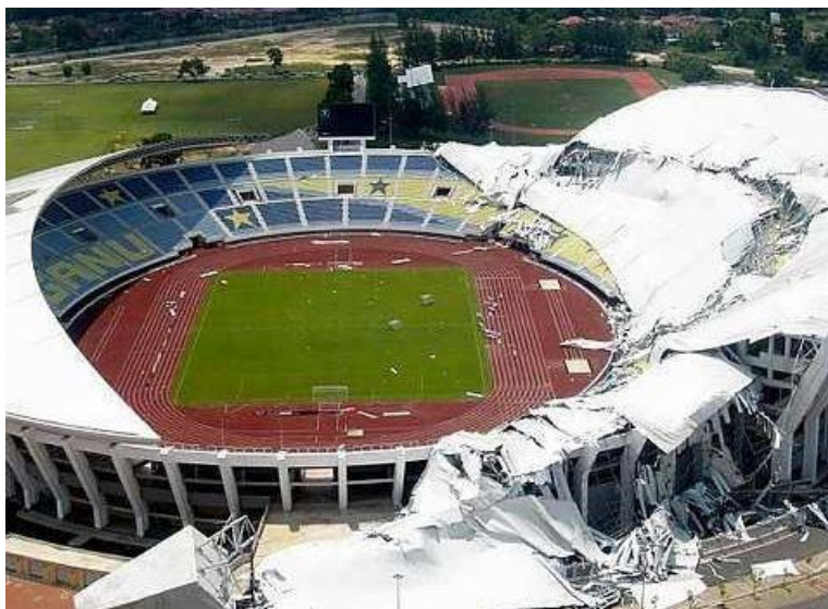
Рис. 4. Покрытие стадиона Gong Badak, 2009 г.
