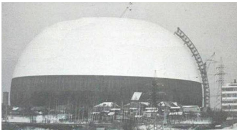
Рис. 3. Купольное сооружение в г. Истра, Российская Федерация - 1985 г.
