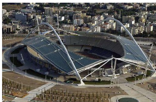
Рис. 19. Стадион «Спирос Луис», висячее вантовое покрытие, год постройки – 2004 г., Афины
