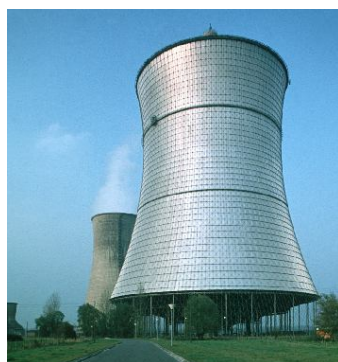
Рис. 27. Тросовая башня градирни с центральным пилоном (Германия)
