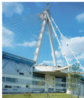
Рис. 6. Вид на ледовый дворец в Крылатском, Москва, со стороны единственного пилона.
