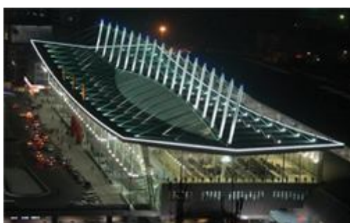
Рис. 12. Покрытие железнодорожной станции, Nanjing, Jiangsu Province, Китай
