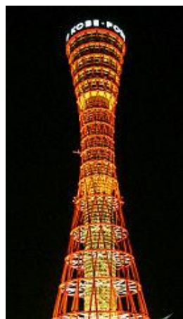
Рис. 26. Гиперболоидная башня в порту Кобе
