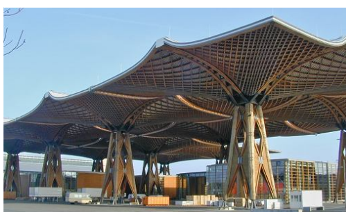
Рис. 35. Сетчатая оболочка из дерева. Hannover Expo-2000, Германия
