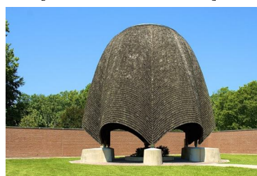
г) Купол из клееной фанеры, покрытый деревянным гонтом, 1960 г., Нью-Хармони, США [8]
