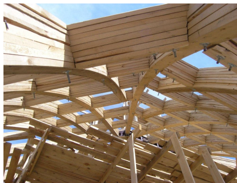
Рис. 39. Фрагмент ребристо-кольцевого купола [ http://newkarkas.ru/?p=95 ]
