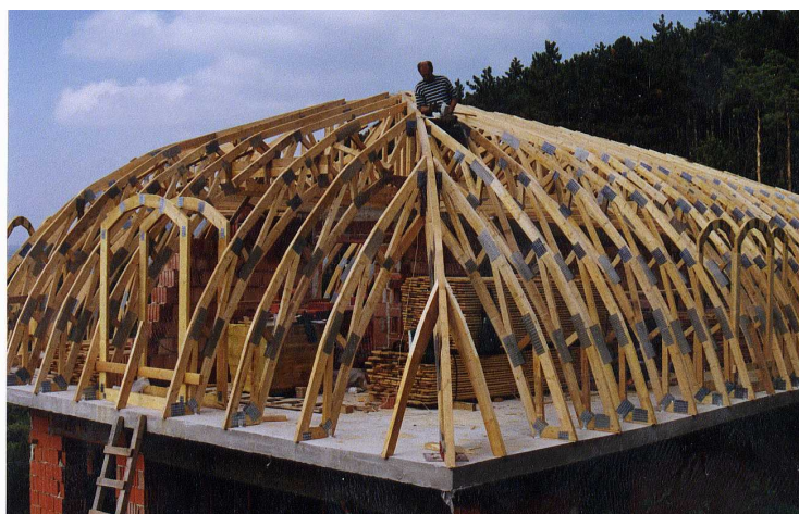
Рис. 41. Несущий каркас ребристого деревянного свода, ООО "МиТекИндастрисРу"
