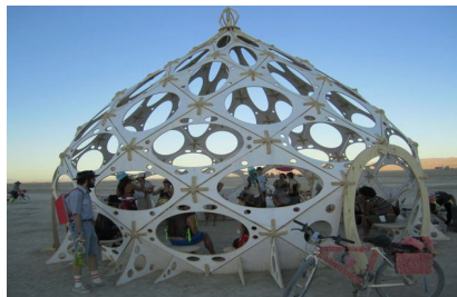
б) Деревянный купол, собранный из модулей, theBurningManFestival, 2010 [cameronannemason.com]
