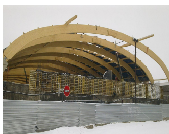
Рис. 15. Деревянный свод арочного типа, спортзал МГСУ, Москва, март 2013 г.
