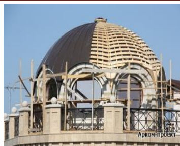
Рис. 14. Деревянный купол в процессе строительства
