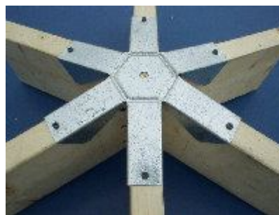
Рис. 37. Узловое соединение геодезического купола
