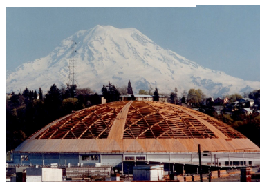
Рис. 18. Сетчатая оболочка покрытия, купол спортивного сооружения в Такоме, США, 1983
