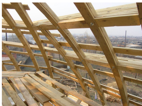
Рис. 38. Меридиональные и кольцевые-ребра ребристо-кольцевого купола из отдельных досок
