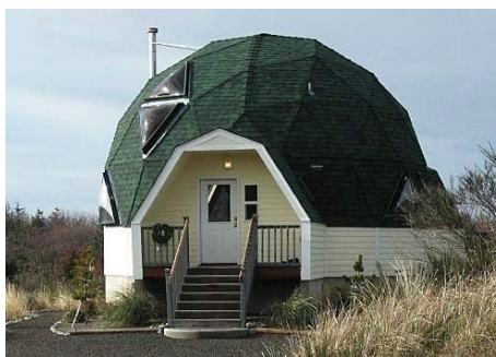
Рис. 27. Геодезический купол с деревянным каркасом из бруса
