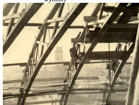
Рис. 3. Строительство купола цирка в Саратове, 1928 г, окончание 1933 г.
