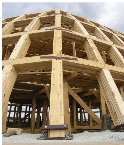
Рис. 40. Законченный каркас купола
