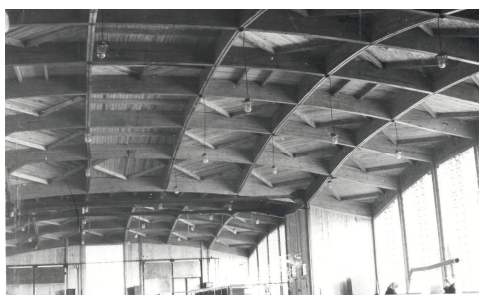
Рис. 23. Покрытие цеха изщитового паркета в г.Волоколамске
