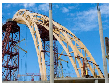
Рис. 17. Ребристая оболочка из древесины в процессе строительства
