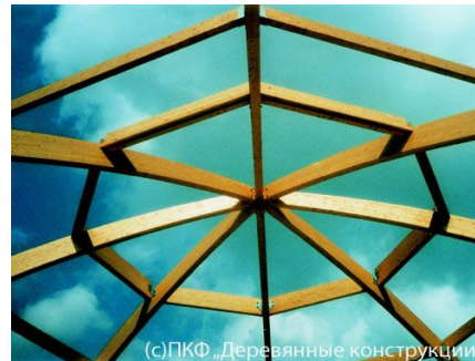
Рис. 21. Фрагмент ребристо-кольцевого купола
