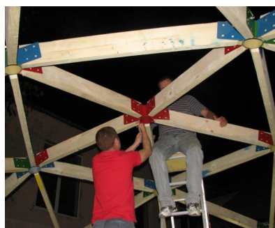
Рис. 28. Сборка деревянного каркаса геодезического купола
