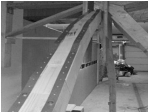
Рис. 5. Общий вид арки усиленной лентами
