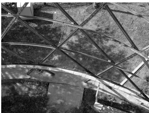
Рис. 1. Для крепления промежуточных колец используются как скобы, так и коротыши
