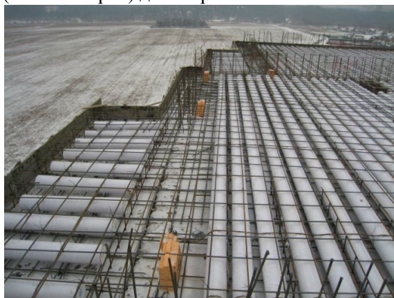
Рис. 2. Арматурокаркас перекрытия и балконной площадки с уложенными пустотообразователями.
