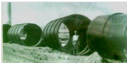
Рис. 1. Образцы тонких стальных труб, которые использовались при проведении натурных испытаниях
