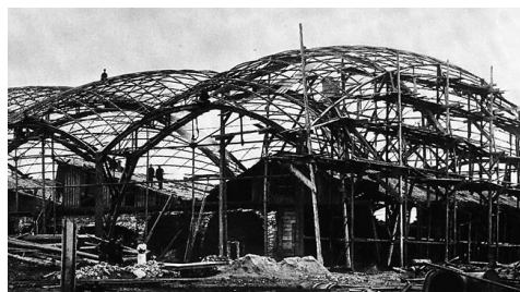
Рис. 6. Сетчатые стальные оболочки положительной гауссовой кривизны, г. Выкса, 1897 (металлургический завод)
