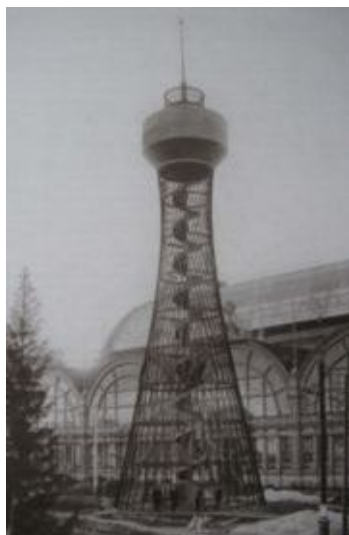
Рис. 5. Водонапорная башня В.Г. Шухова в форме однополостного гиперboloида вращения (первая в мире гиперболическая конструкция на Всероссийской выставке в Нижнем Новгороде, 1896)
