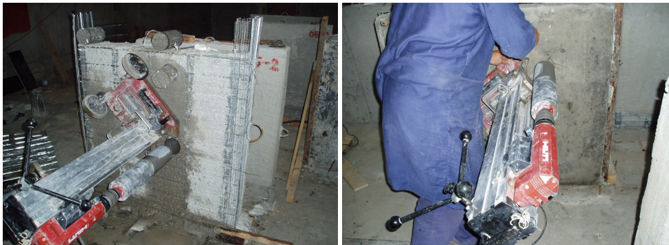
Рис. 3. Отбор проб бетона из опытных образцов для определения прочности
