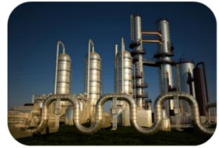
химическая и нефтехимическая промышленность (производство химического волокна, резинотехнических изделий)
