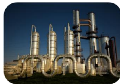
химическая и нефтехимическая промышленность (производство химического волокна, резинотехнических изделий)
