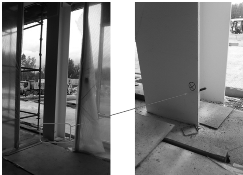
Рис. 2. Общий вид деформационной марки на несущей стальной колонне [General view of the deformation of the brand on the supporting steel column]
