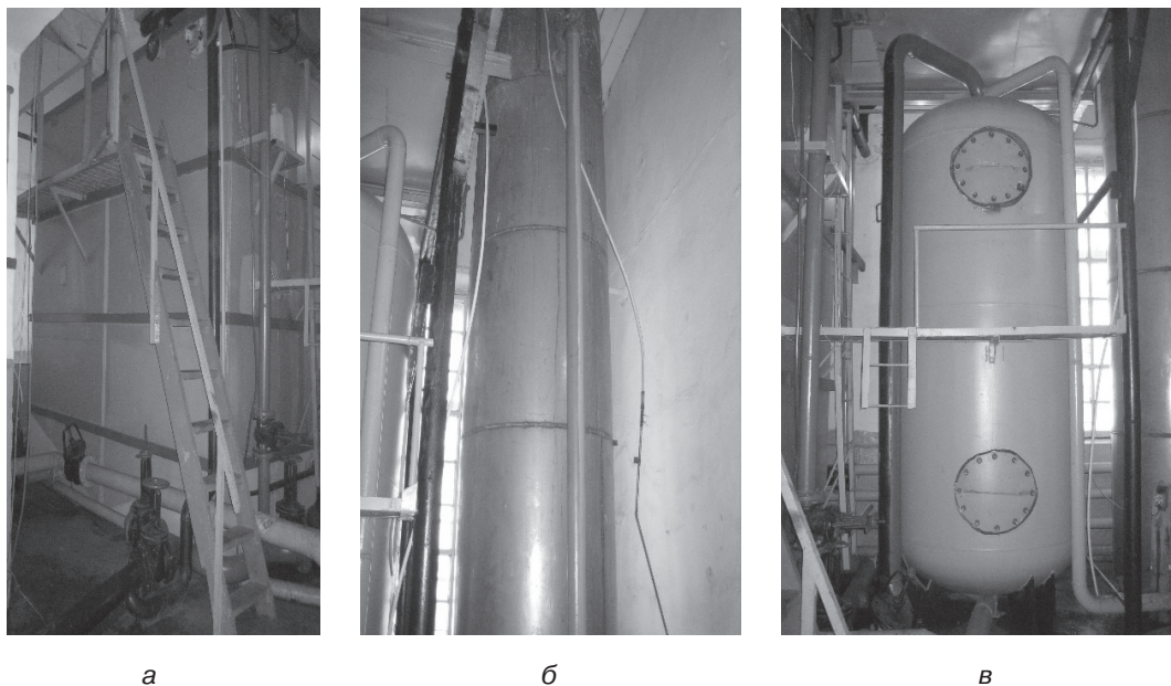
Рис. 3. Станция подготовки питьевой воды: а) осветлительный двухступенный фильтр с инертными загрузками; б) контактная колонна постозонирования воды; в) сорбционный фильтр [Station potable water a) clarification two-stage filter with inert downloads; b) contact the column of polotnyany water; c) a sorption filter]
