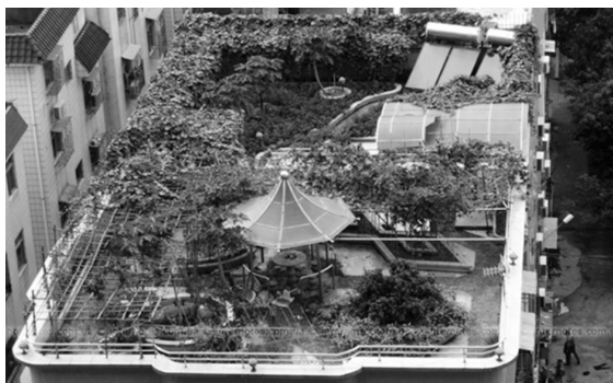
Рис. 3. Пример интенсивного типа озеленения кровли
