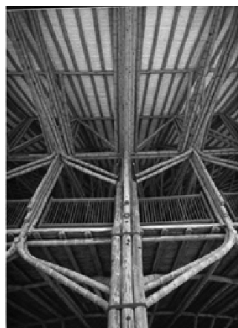
Рис. 4. Внешний вид павильон ZERI (а); детали колонны из бамбука (б)
