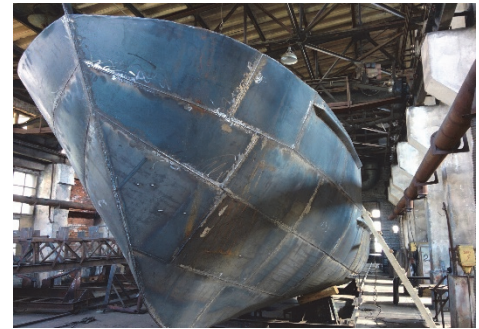
Рис. 3. Корпус судна, аппроксимированный кусками торсовой обшивки (фотография с сайта http://www.ladverf.ru/page/3/ ) Figure 3. The ship hull that is approximated by the fragments of torse skin (photo from the website http://www.ladverf.ru/page/3/ )
