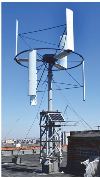
**Рис. 4.** Ветроэнергетическая установка ВЭУ-3 с солнечным модулем (фотография сделана автором)
