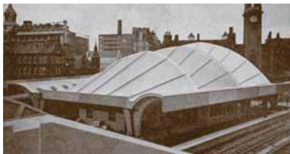
Рис. 11. Коноидальное покрытие железнодорожной станции “Oxford Road Station”, Манчестер, Англия, 1960
