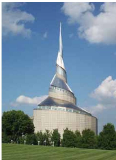
Рис. 13. Спиральная крыша [Figure 13. A spiral roofing]
