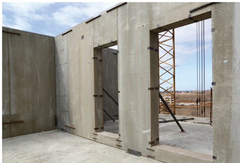
Рис. 2. Несъемная опалубка в рабочем положении [ Fig. 2. Stay-in-place formwork in position]
