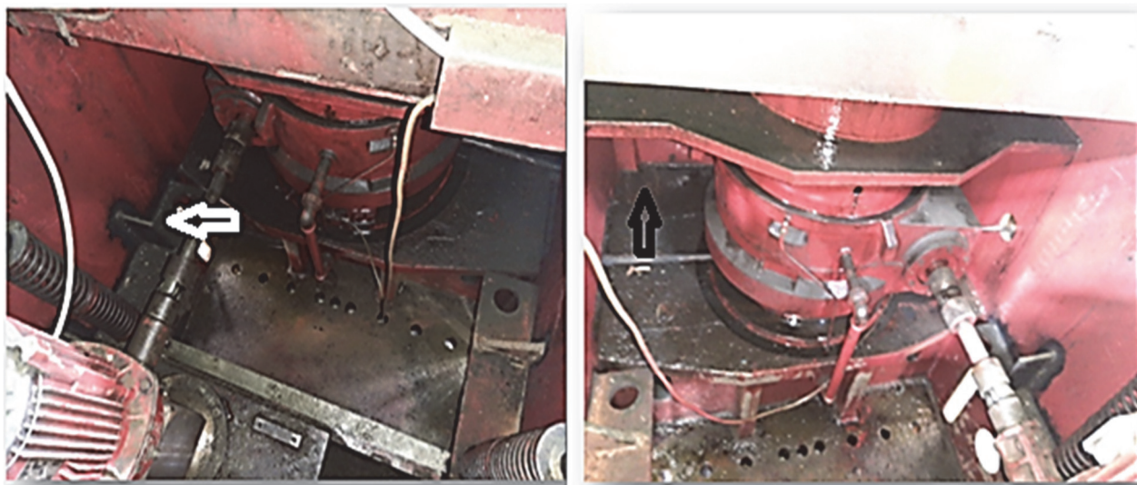
Рис. 2. Трещины в ползуне, выявленные в процессе обследования (фото Чжо Заяр) Figure 2. Cracks in the slider revealed during the examination (photo by Kyaw Zaya)
