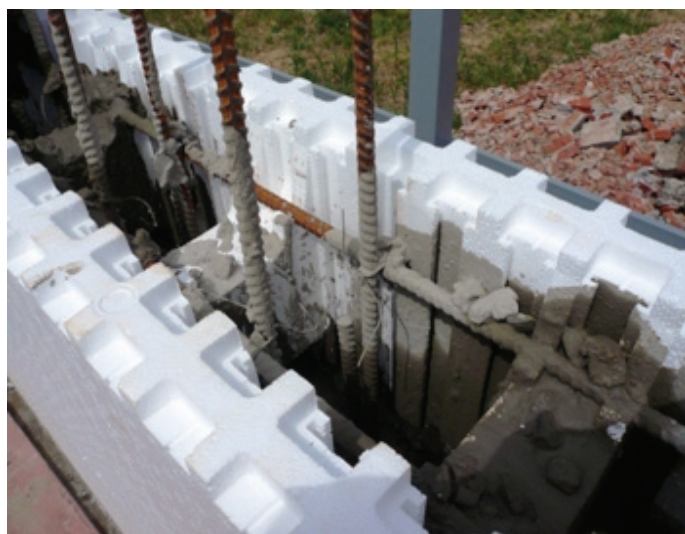
Рис. 3. Изготовление испытуемых фрагментов стеновых ограждений
