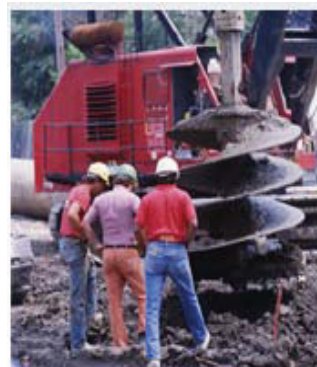
Рис. 2. Буровая машина с прямым геликоидом
