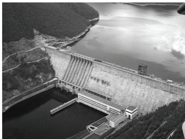
Рис. 6. Гидроузел Зейской ГЭС/ с массивно-контрфорсной плотиной
