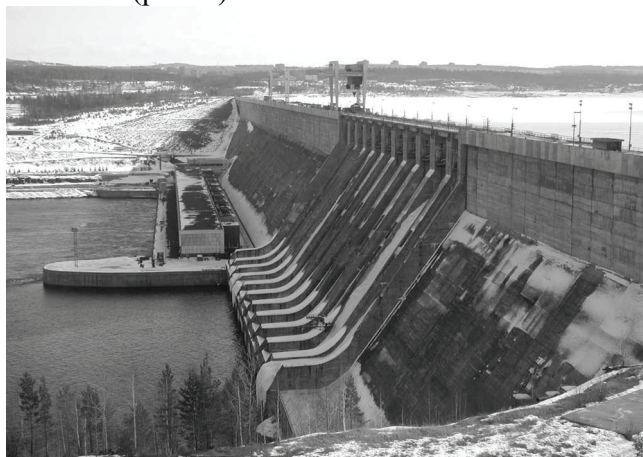
Рис. 4. Гравитационная плотина Усть-Илимской ГЭС
