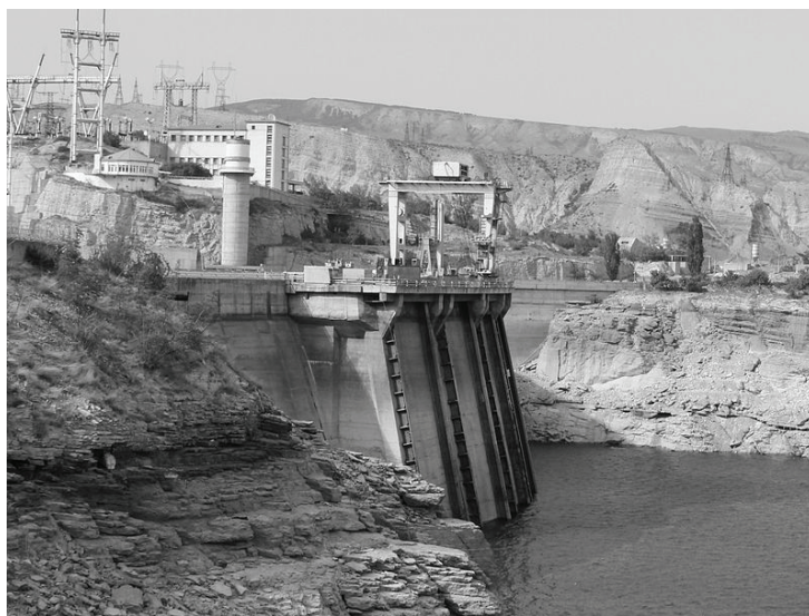
Рис. 10. Водоприемник Чиркейской ГЭС
