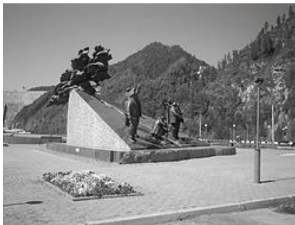
Рис. 1. Смотровая площадка Саяно-Шушенской ГЭС
