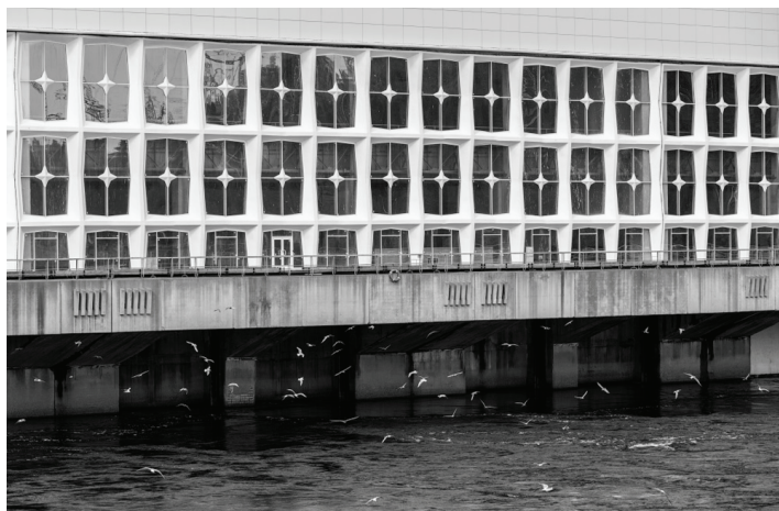
Рис. 8. Вид на здание Зейской ГЭС с НБ
