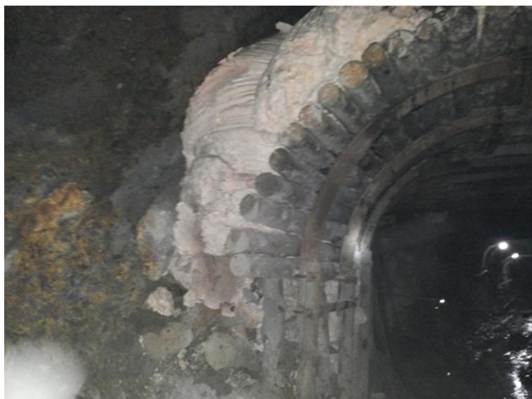
Рис. 1. Состояние забутовки пустот закрепного пространства из фенольной смолы «Блокфил» после проведения буровзрывных работ, вид со стороны забоя при отставании крепления от груди забоя 4 м
