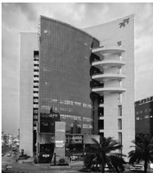
Fig. 2. Al Rostamani Office and Residential Building, Dubai, UAE, 2005 [Рис. 2. Аль Ростамани офисные и жилые здания, Дубай, ОАЭ, 2005]
