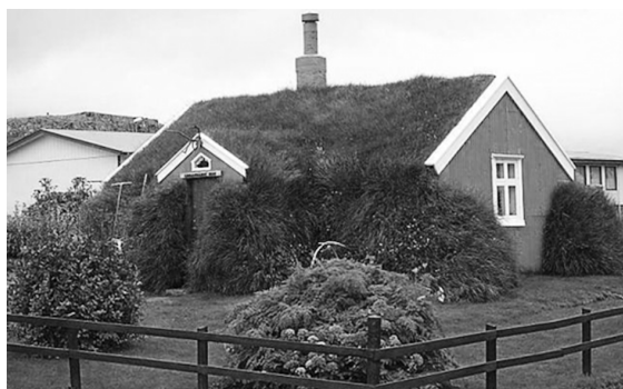
Рис. 2. Пример экстенсивного типа озеленения кровли
