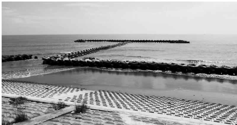
**Рис. 5.** Типичный комплекс берегозащитных и пляжеудерживающих конструкций (2014 г.)
