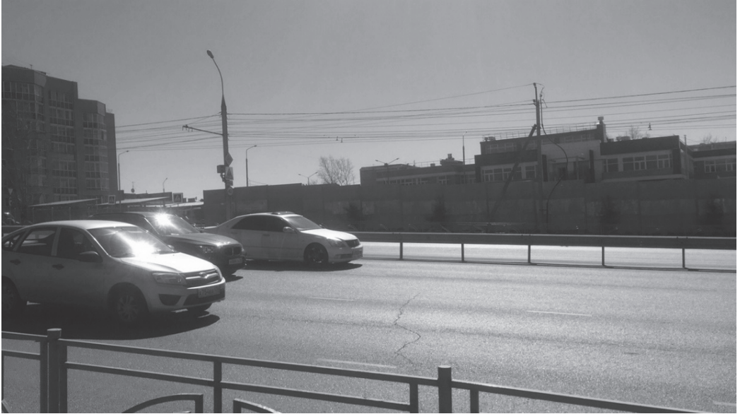
Рис. 7. Шумозащитный экран на ул. Байкальская г. Иркутска [ Figure 7. Noise screen on Baikalskaya Street of Irkutsk]
