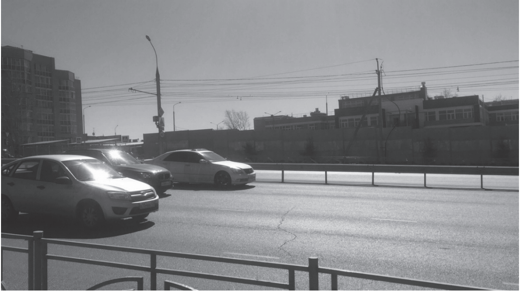
Рис. 7. Шумозащитный экран на ул. Байкальская г. Иркутска [ Figure 7. Noise screen on Baikalskaya Street of Irkutsk]
