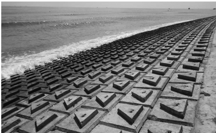
Рис. 3. Типичная волногасящая откосная стенка с морской стороны дамбы (2014 г.)
