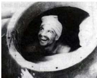
На строительстве Кольцевой дороги
