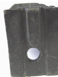
Рис. 7. Вид разрушения консоли в подпятнике
