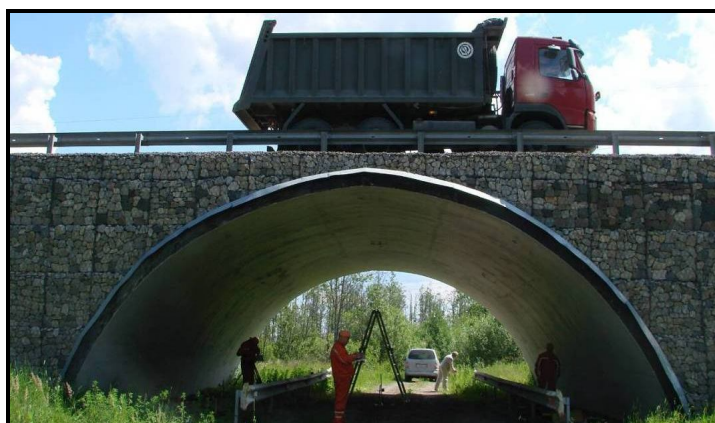
Рис. 1. Общий вид моста при статических испытаниях
