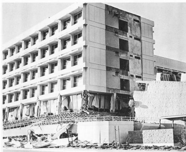
Рис. 1. Здание с "гибким" первым этажом, пострадавшее при землетрясении в г. Сан-Фернандо (США) 9.02.1971 г.
