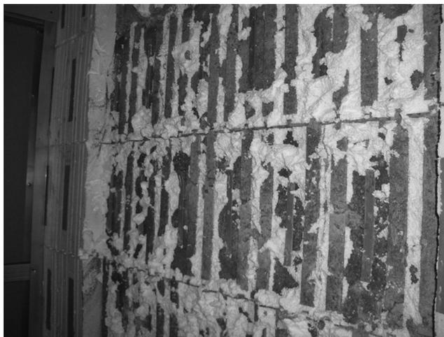
**Рис. 3.** Фрагмент стены со снятым слоем пенополистирольной опалубки
