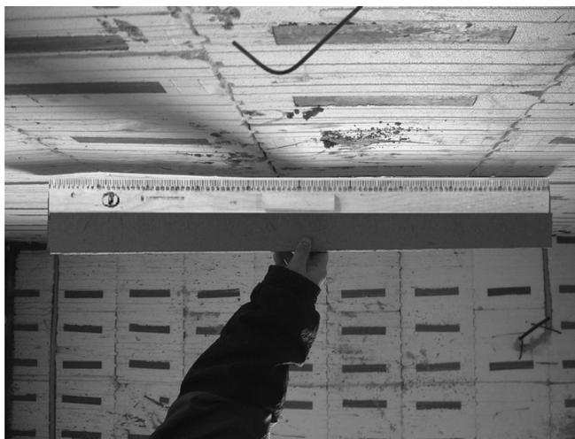
Рис. 1. Выявленное отклонение поверхности потолка от проектного положения
