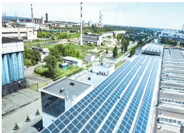
Рис. 3. СЭС на кровле завода «Русские электрические двигатели» [11] [Figure 3.] Solar power plant on the roof of the plant “Russian Electric Motors” [11]
