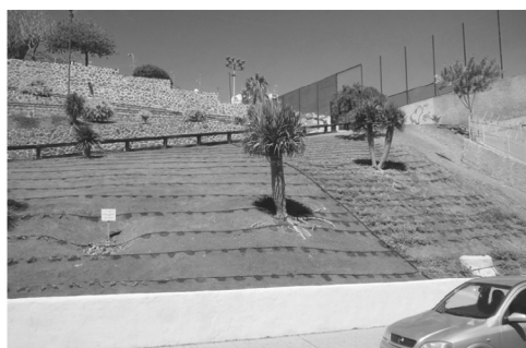
Рис. 3. Капельный полив городских насаждений вдоль дорог (Лас Палмас де Гран Канария, Испания) (фото Г. Донбаевой, 2013—2014 гг.)
