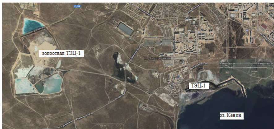
Рис. 1. Общий вид ТЭЦ-1 и золоотвала [Figure 1. General view of CHP-1 and ash dump]
